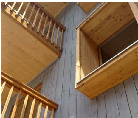
Einfache Lösung für komplexe thermische Probleme: Die weit herausgezogenen Fensterlaibungen machen einen außenliegenden Sonnenschutz obsolet
