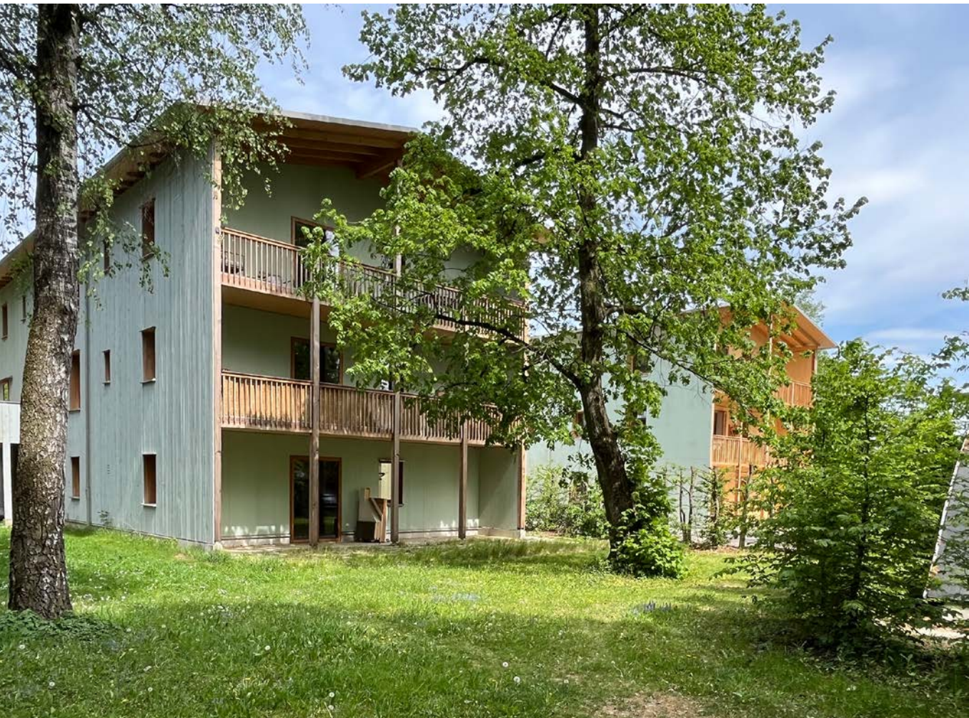
Forschungshaus Nr. 4 ist ein „Halb-Massivholzbau“. Die Fassaden erhielten eine Dämmschicht, die gleichzeitig die Außenhülle bildet. Innen sind Lehmziegelwände Feuchtepuffer und thermische Speichermasse zugleich
