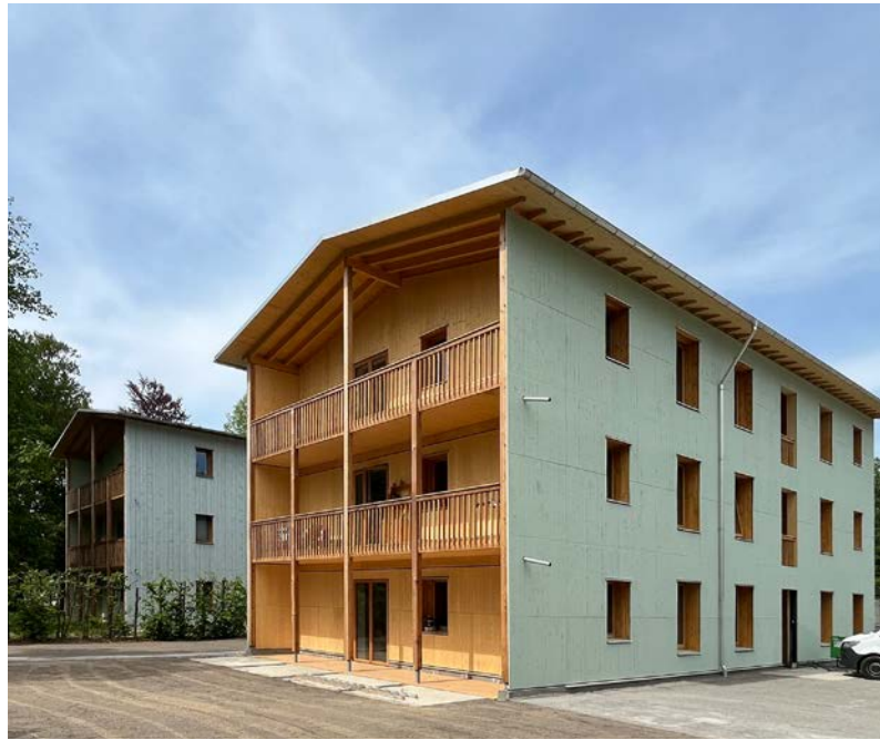
Das Forschungshaus Nr. 5 wurde im Mai 2026 bezogen. Es kombiniert vorgefertigte Holzfassadenelemente mit tragenden Kaltziegelwänden und Lehm-Holz-Massivdecken und ist auf bis zu 8 Geschosse erweiterbar
