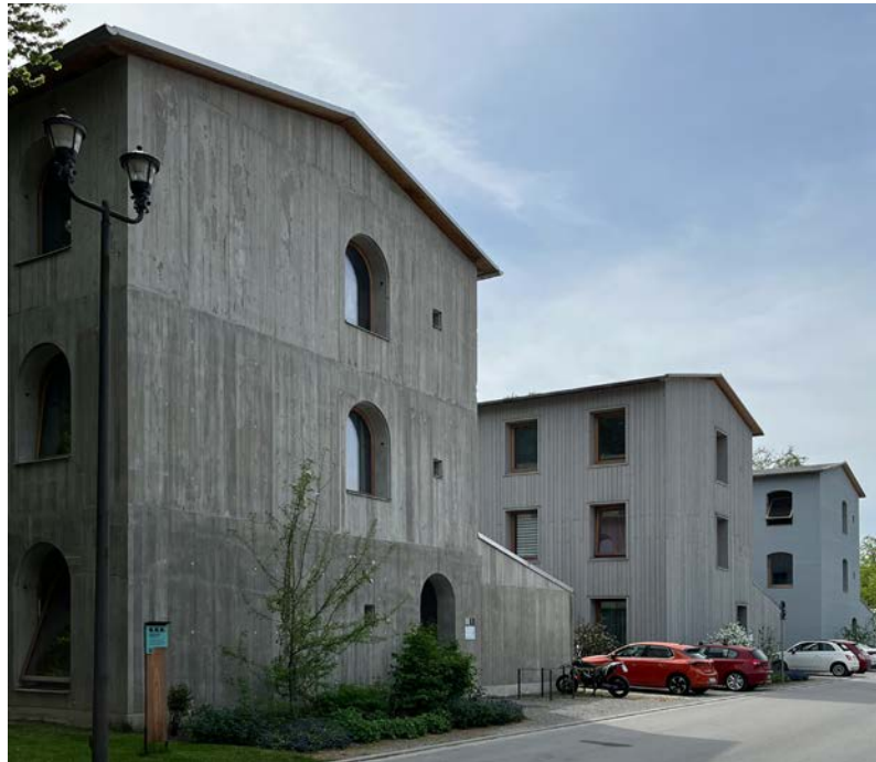
Klassiker des einfachen Bauens: Die Forschungshäuser 1 bis 3 auf dem Campus in Bad Aibling. Die Erkenntnisse des umfangreichen Monitorings flossen in die Nachfolgeprojekte ein
