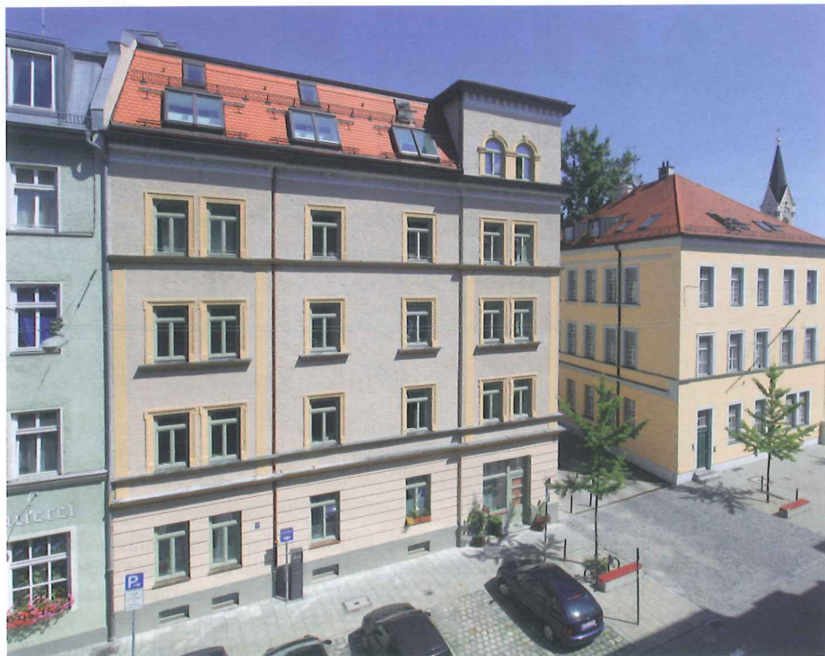
Eine Außendämmung kam aufgrund der Denkmalschutzauflagen nicht in Frage. Quelle: Knauf
