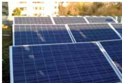
Der in den PV-Modulen erzeugte Gleichstrom wird in PV-Wechselrichtern, die in der Tiefgarage installiert wurden, in Wechselstrom gewandelt und in das öffentliche Netz eingespeist. Der Einspeisezähler der Münchner Stadtwerke zeigte für den März 2012 eine Produktion von 1448 kWh Strom an. Im Vergleich hierzu lag der verbrauchte Hausstrom (Allgemeinstrom für Beleuchtung, Aufzug, Heizung, Waschküche, Tiefgarage) im Monat März bei 1237 kWh. Durch den Einbau von Zwischenzählern für größere
